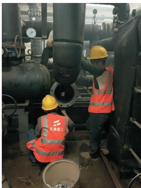
图 7 更换换热站管路部件
