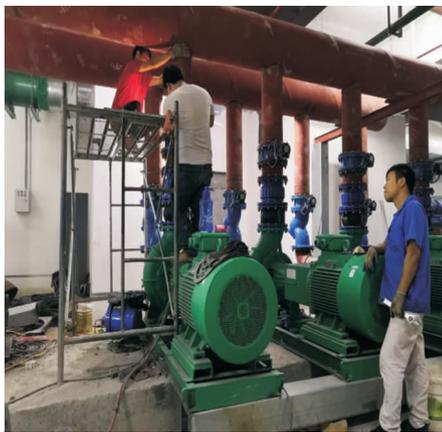
图5 水泵与水管连接安装
