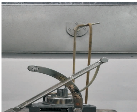
图7 喷水室风管测速装置
